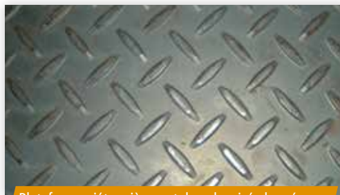
Plateforme piétonnière en tôle galvanisée larmée
